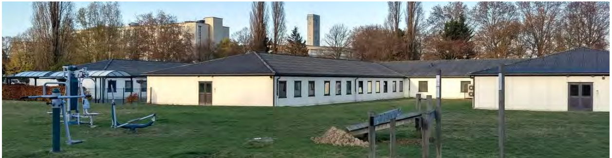
Figure 59 : Vue 2, Bâtiment et espace vert côté intérieur du site (ARIES, 2018)
