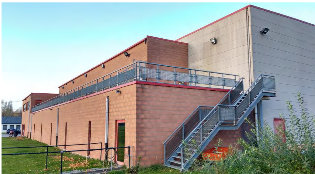
Figure 63 : Vue de la façade Sud du bâtiment (ARIES, 2018)
