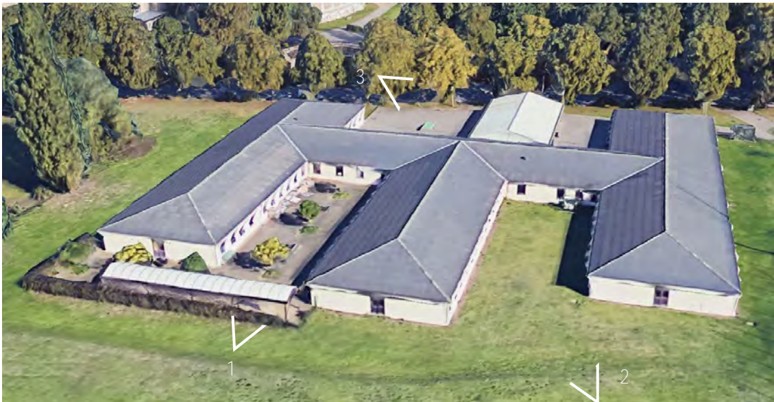
Figure 57 : Vue du bâtiment existant à l'Ouest du site (ARIES sur fond Google Earth, 2018)
