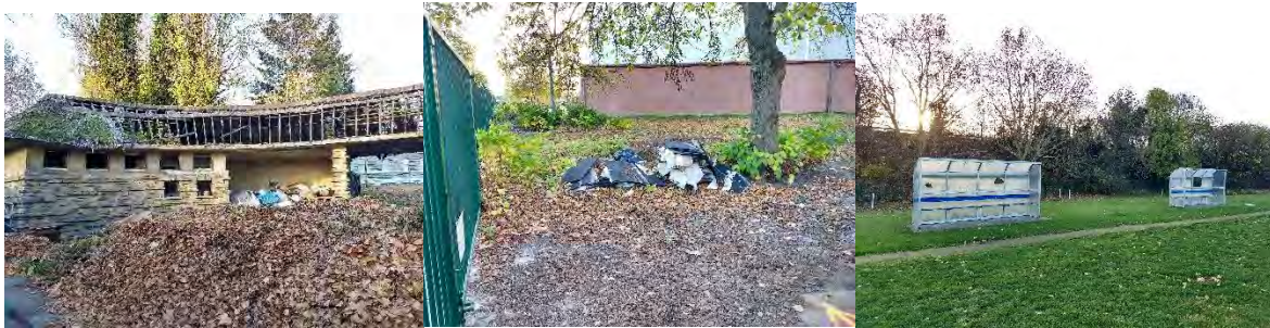
Figure 143 : Illustration d'équipements et de dépôts à proximité du site et sur le site (ARIES, 2018)
