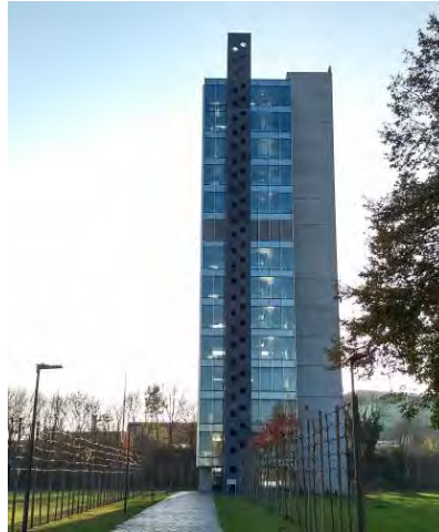
Figure 51 : Vue depuis le Sentier de la Drève de la « Kitchen Tower » (ARIES, 2018)
