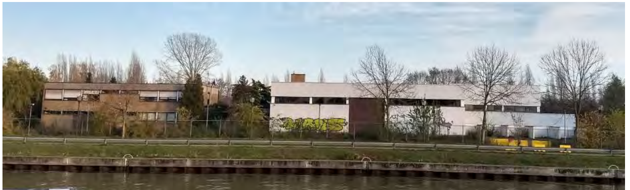
Figure 52 : Vue des bâtiments industriels de l'autre côté du Canal (ARIES, 2018)
